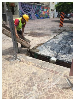
5. Đổ bê tông
