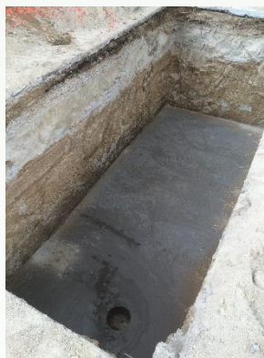
2. Xây nền hố
