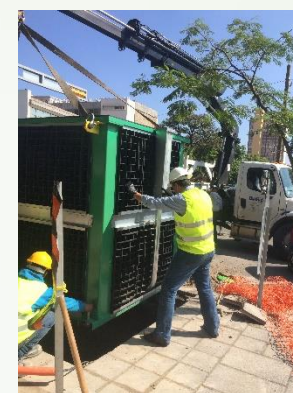
3. Đặt thiết bị vào hố
